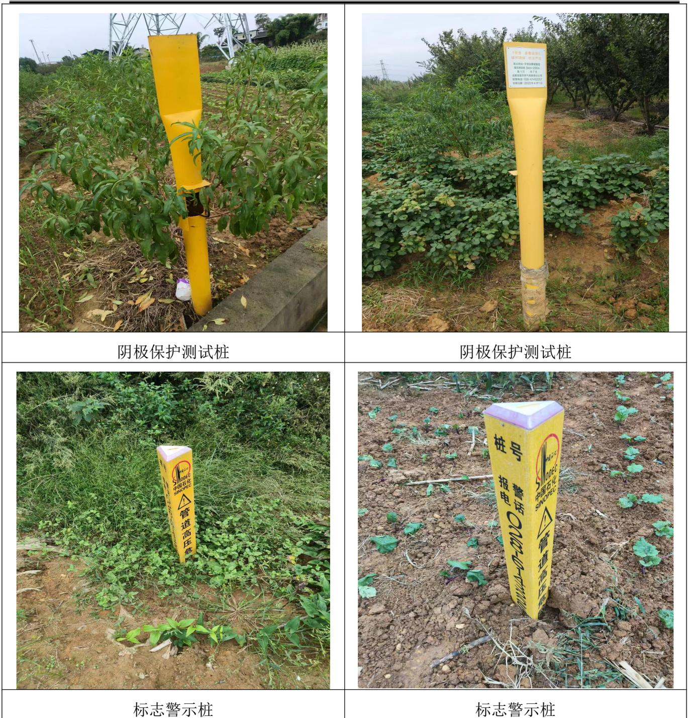
图3-4 管道标准桩等实景照片
