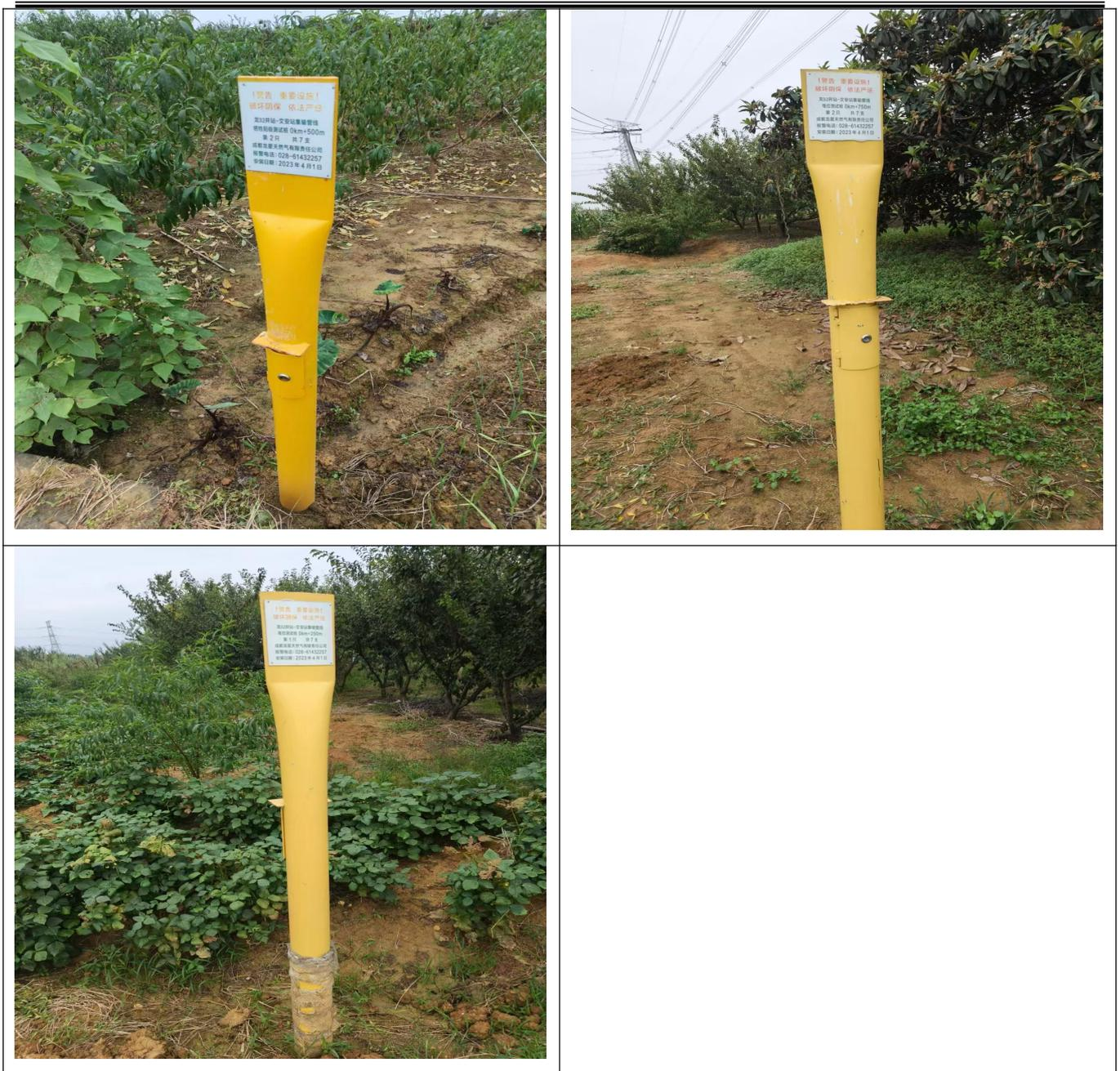
图3-3 管道阴极保护测试桩实景照片
