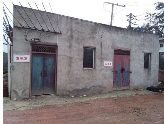
配电室、发电室
